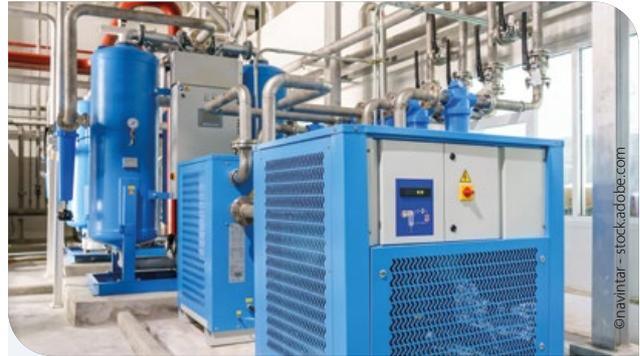
**AUFGABENSTELLUNG:** Ein Druckluftkompressor soll in die Energieoptimierung mit eingebunden werden. Wenn der Druck am Druckluftbehälter unter einen bestimmten Wert fällt, muss der Kompressor wieder eingeschaltet werden.
