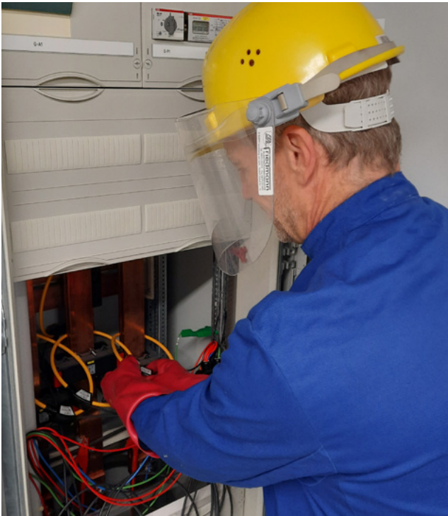
Einbau eines Messgerätes
