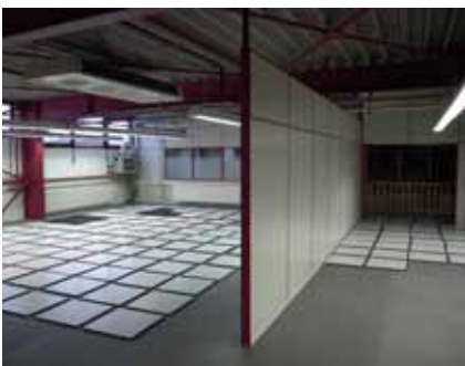
Der neue Fußboden ist das „Herzstück“ des ESD Schutzes in den neuen Fertigungsräumen.
